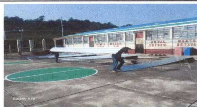
FOTO 4 desinstalacion de techo
