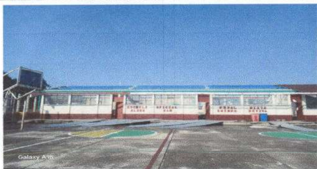
FOTO 1 desinstalacion de techo
