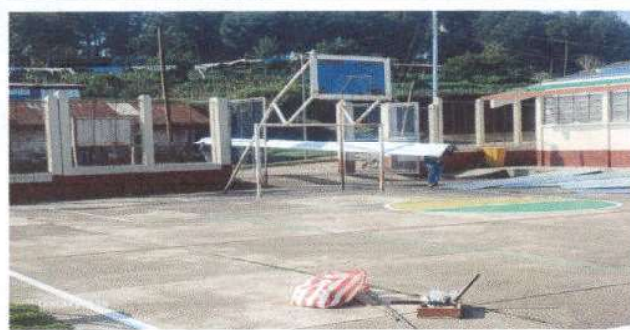
FOTO 2 desinstalacion del techo
