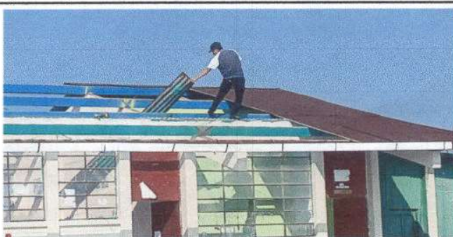
FOTO 5 desinstalacion del techo
