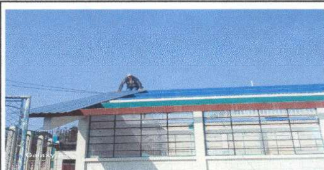
FOTO 6 desinstalacion del techo
