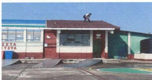
FOTO 3 desinstalacion del techo
